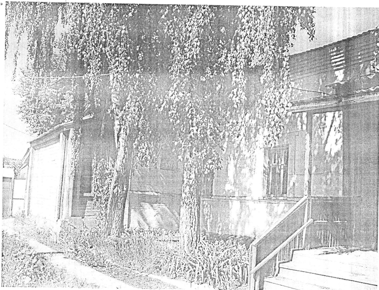
Фото №3. Фрагмент юго-восточного фасада.
